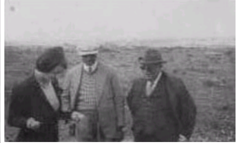
Henry et Albert (sondage pour puits 45m)
