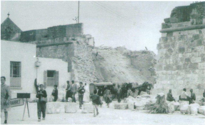
Tunis : Bab sidi Kasim au moment des démolitions
